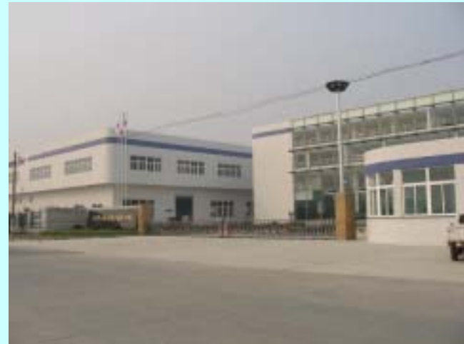
上海工場新棟
