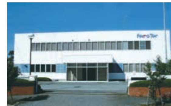
千葉工場外観
