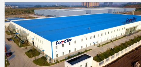
洗浄工場(内江第2)
