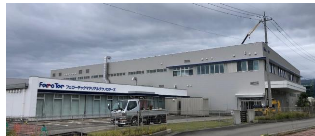
石川開発センター隣接第2工場 セラミックス拠点 ※正面右奥が第2工場
