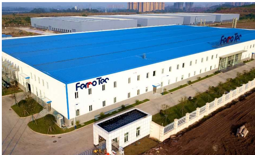
内江洗浄工場 2号棟
