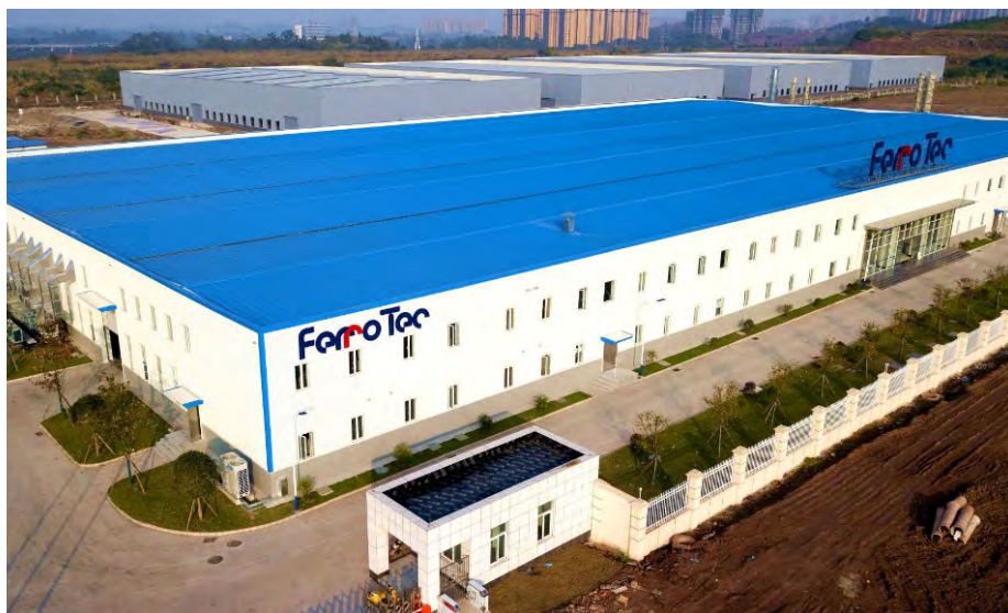
内江洗淨工場 2号棟
