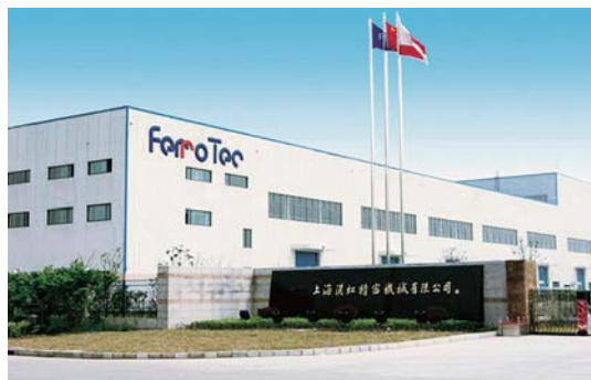
太陽電池関連製品を生産する上海漢虹精密機械有限公司
