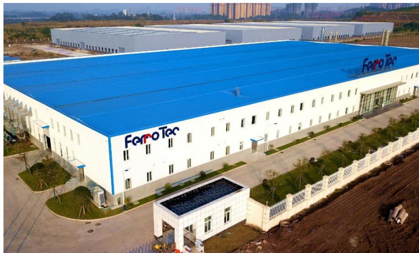
内江洗浄工場 2号棟
