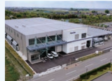
石川第2工場 外観
