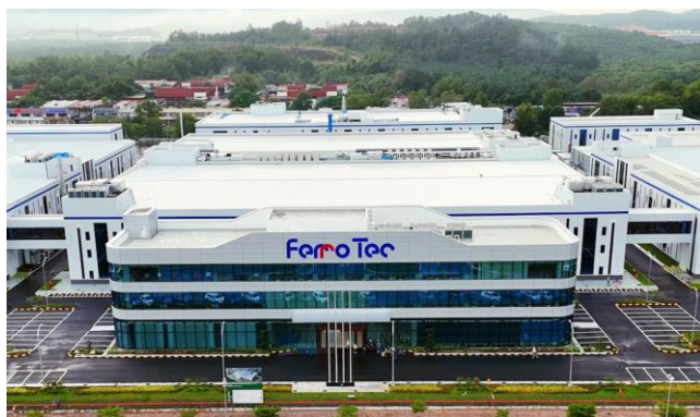
マレーシア・ケダ新工場外観（正門前）
