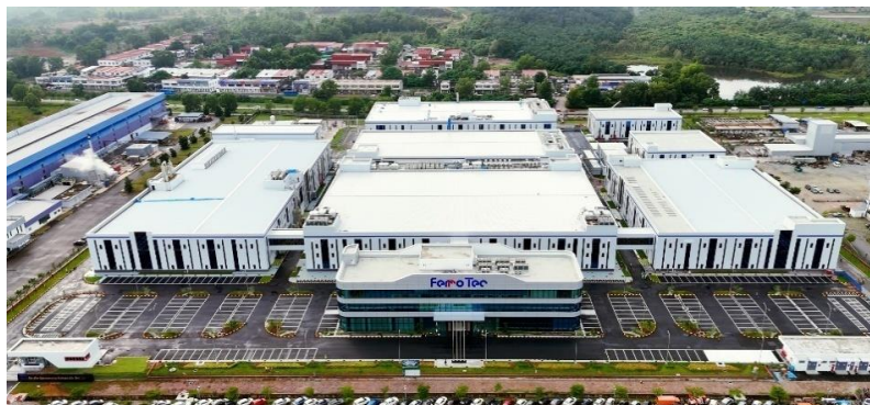
クリム第一工場 (マレーシア)
