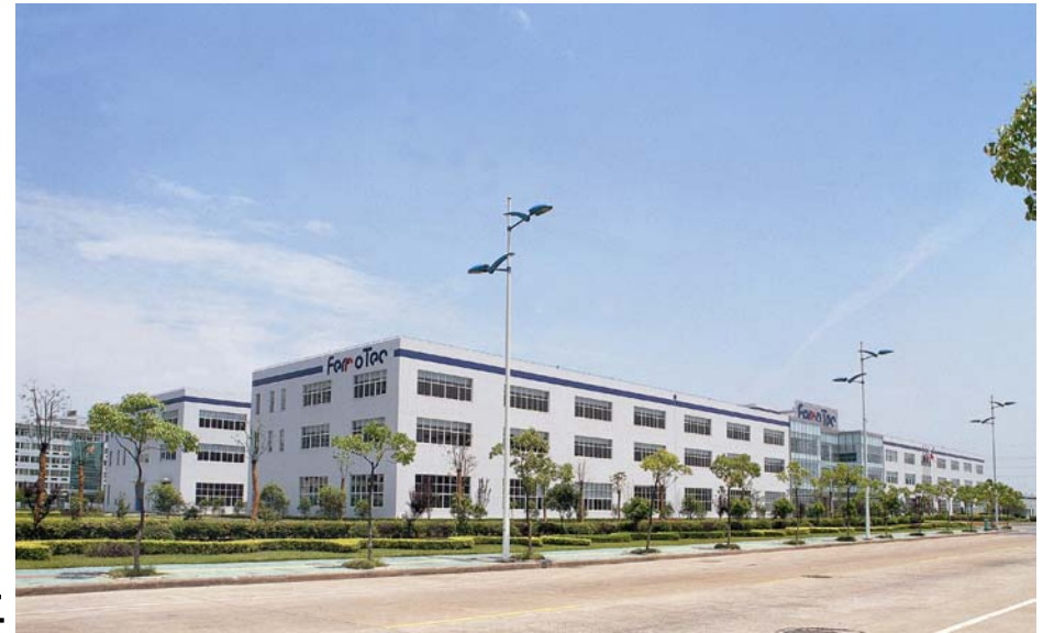
杭州濱江第二工場5月竣工
